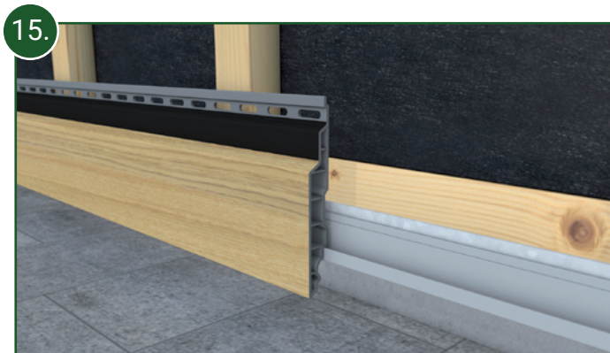
15. Das Zusägen der Fassadenprofile kann mittels Kappsäge, Handkreissäge, Stichsäge etc. erfolgen. Bitte verwenden Sie hierzu möglichst feinzahnige Sägeblätter!
